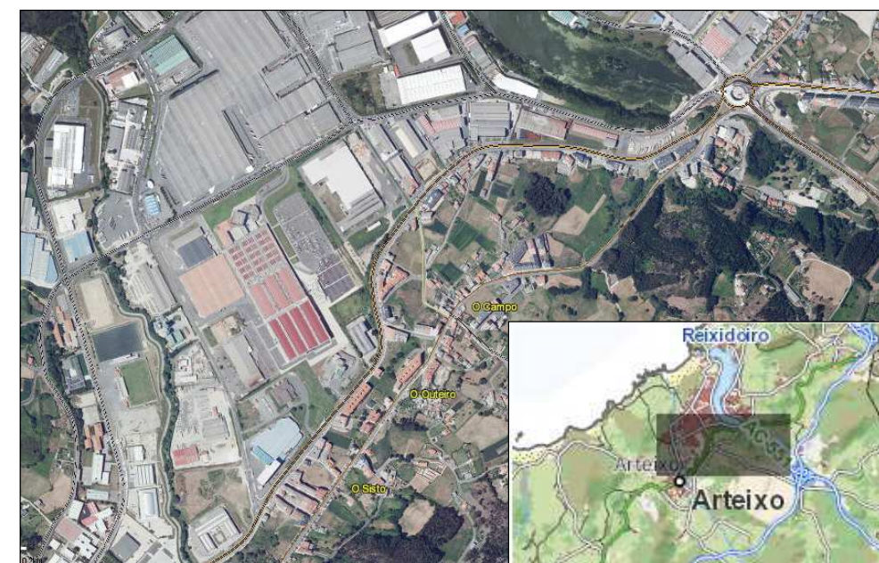
Fotografía aérea de la zona de actuación
