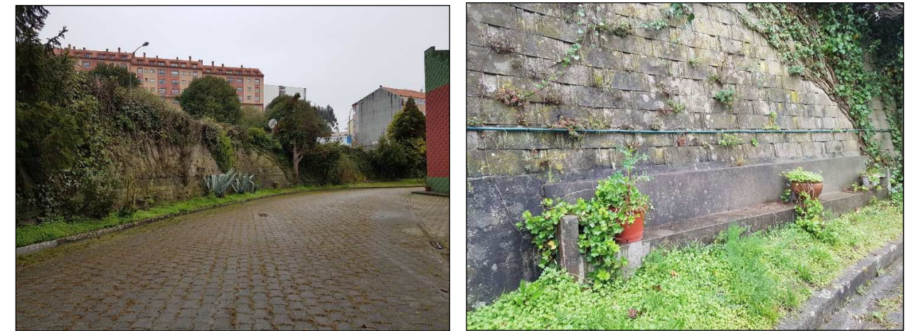
Vista el muro de bloque actual
