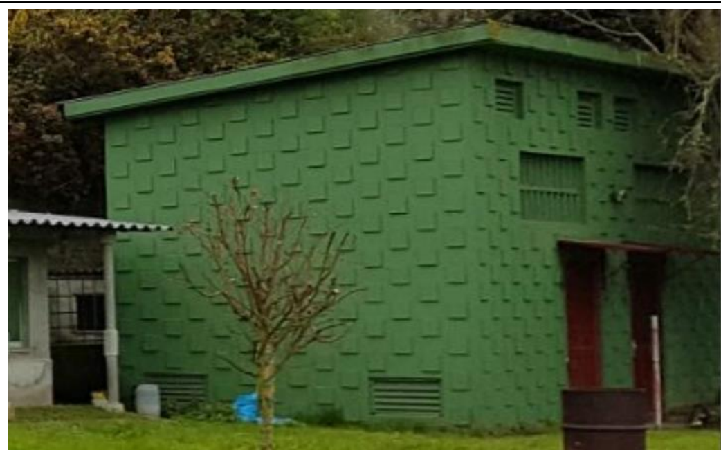
Almacén afectado. Parcela 0359904NH4905N0001HO
